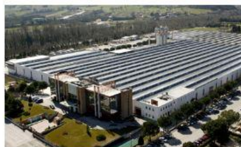
1993 Il nuovo stabilimento
